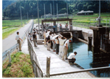
東西分水工（加西市上芥田町） ダム用水が唯一目視できる施設
