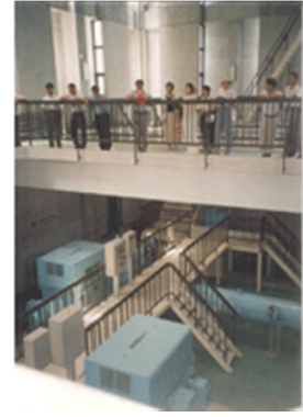
杉原川揚水機場ポンプ室視察
