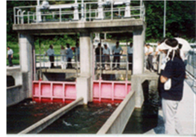
東西分水工 右側西幹線 左側東幹線
