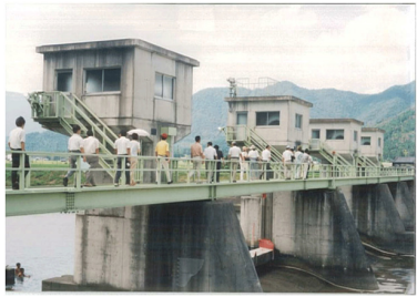
杉原川高田頭首工
