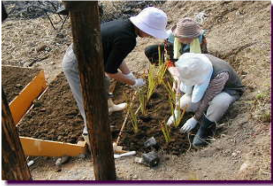
水生植物の植栽
