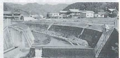
取水口（万願寺川井堰）
