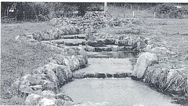
親水機能を持つ善防池分水工 (両月町)
