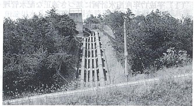
善防チェックスタンド管水路
