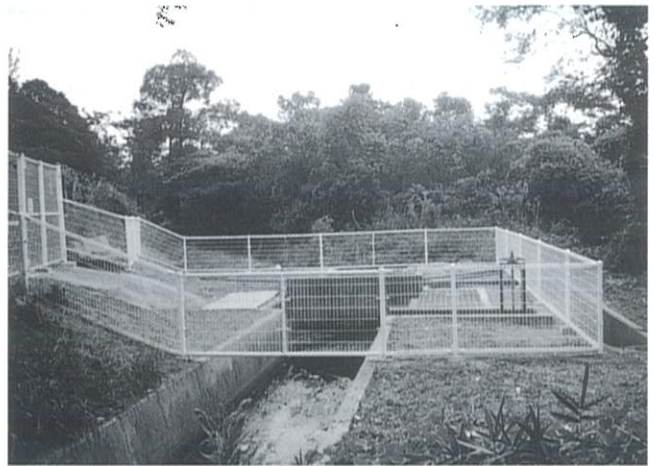
2号分水口(フラワーセンター内)
