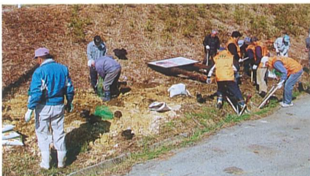
善防CSの整備と案内看板の設置
