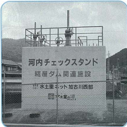
(河内チェックスタンドー加西市河内町)
