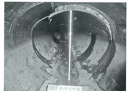
管内漏水箇所（たわみ・クラック）
