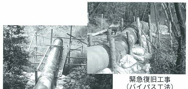
管内漏水箇所（たわみ・クラック）
