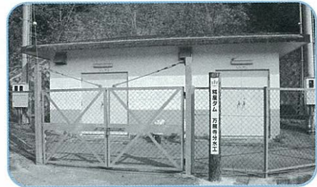
(万願寺分水工ー加西市上道山町)
