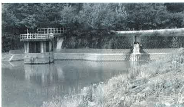
古新池分水口（小野市復井町）
