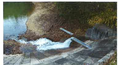
新ヶ池分水口（加西市青野町）
