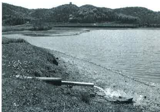
大池分水口(加西市田原町)
