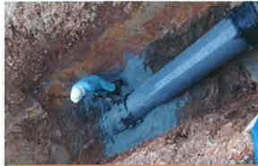
漏水した管水路(VUφ500)の 復旧状況
