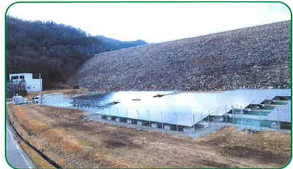
糶屋ダム堤体下の太陽光発電施設
