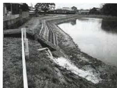
貯水位の低下したため池へ補給
