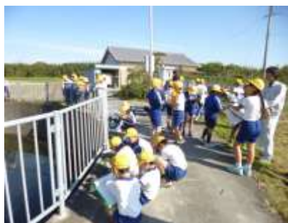
東条川疏水「六ヶ井円筒分水工」
