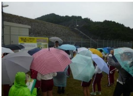
糶屋ダム堤体下の太陽光発電施設
