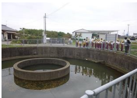
東条川疏水「六ヶ井円筒分水」
