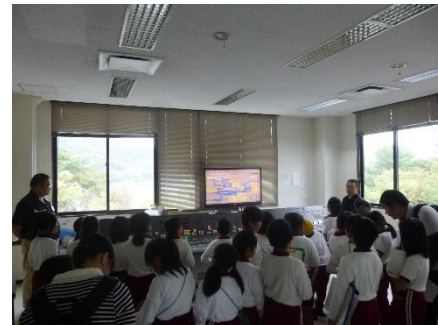
糶屋ダム管理所操作室
