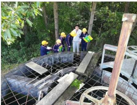
東条川疏水「加茂線分水工」
