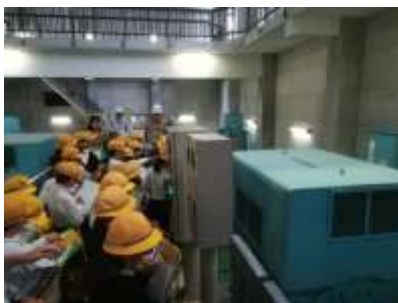
杉原川揚水機場
