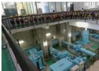
杉原川揚水機場
