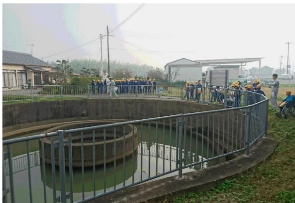
東条川疏水「六ヶ井円筒分水」
