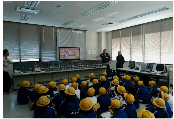
糶屋ダム管理所操作室
