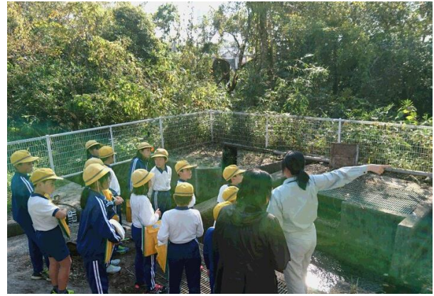
豊倉町の2号分水工
