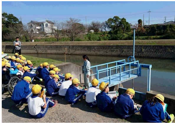
殿原町の飯盛野疎水取水口
