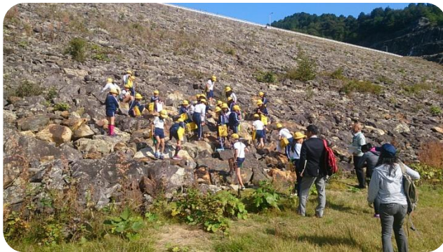
実際のダム堤体を間近に見て
