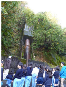
ダムへの送水管
