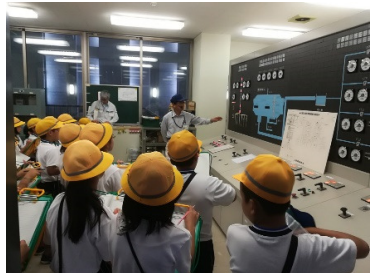
杉原川揚水機場
