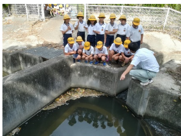
飯盛野疏水2号分水工
