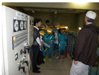
杉原揚水機場
