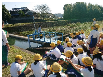
飯盛野疏水取水口
