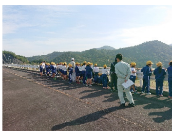
糶屋ダム堤体
