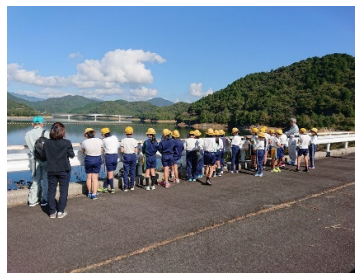
糶屋ダム堤体
