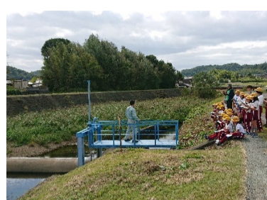
殿原町にある疏水取水口
