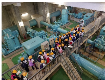
杉原揚水機場操作室
