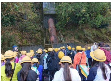
杉原川揚水機場横の導水管
