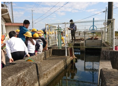
飯盛野疏水3号分水工
