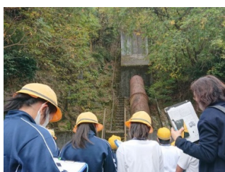
杉原川揚水機場横の導水管
