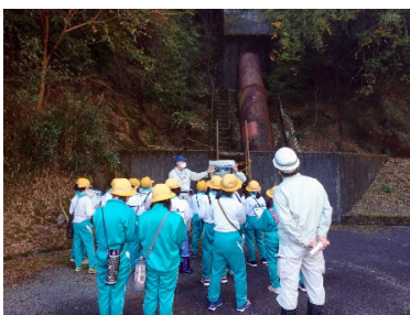
杉原川揚水機場横の導水管
