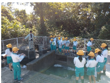
飯盛野疏水2号分水工
