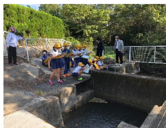
飯盛野疏水2号分水工
