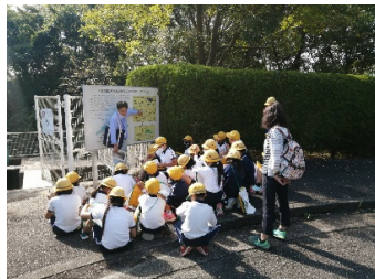
飯盛野疏水2号分水工
