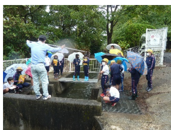
飯盛野疏水2号分水工
