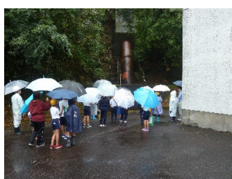
杉原川揚水機場横の導水管
