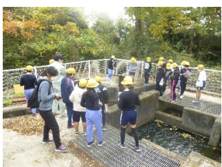
飯盛野疏水2号分水工
