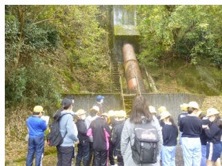
杉原川揚水機場横の導水管
