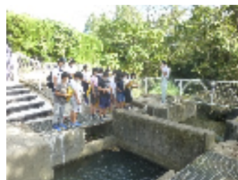
飯盛野疏水2号分水工
