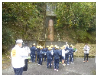
杉原川揚水機場
