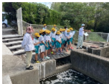
飯盛野疏水2号分水工
