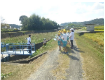
飯盛野疏水取水口
