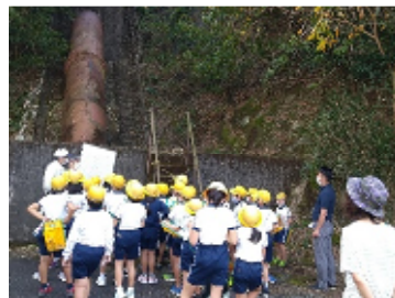
杉原川揚水機場
