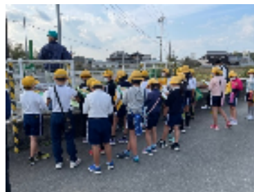
飯盛野疏水3号分水工
