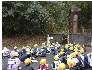
杉原川揚水機場
