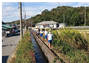
3号分水工から奉天池
