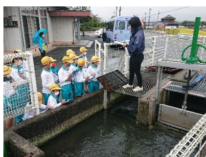
飯盛野疏水3号分水工
