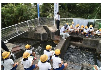
飯盛野疏水2号分水工(1)
