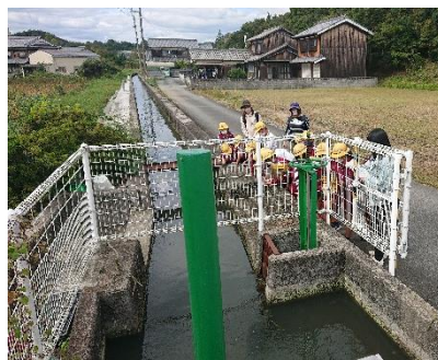
飯盛野疏水3号分水工
