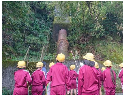
杉原川揚水機場横の導水管
