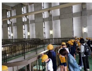
杉原川揚水機場
