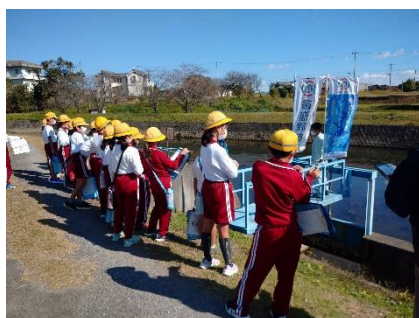
飯盛野疏水取水口
