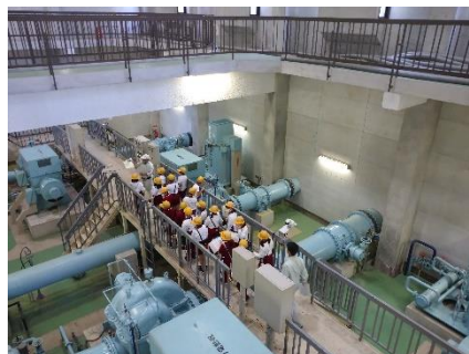
杉原川揚水機場
