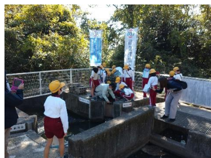
飯盛野疏水2号分水工
