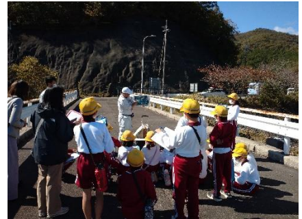
糶屋ダムの堤体
