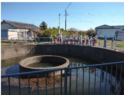
六ヶ井円筒分水工
