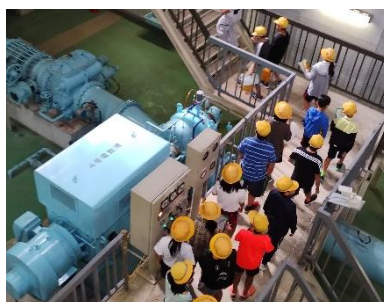
杉原川揚水機場
