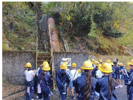
杉原川揚水機場
