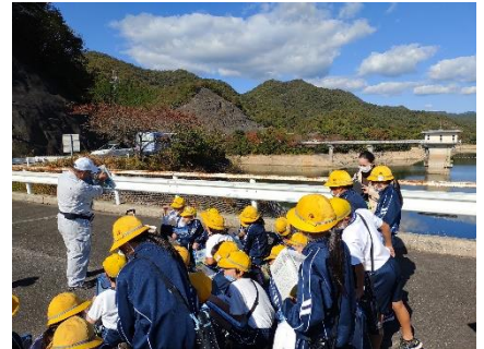
糶屋ダムの堤体
