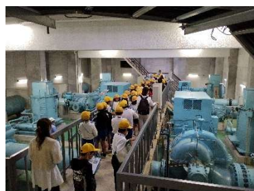
杉原川揚水機場
