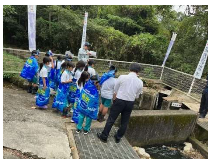
飯盛野疏水2号分水工
