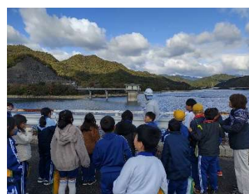
糶屋ダム堤体
